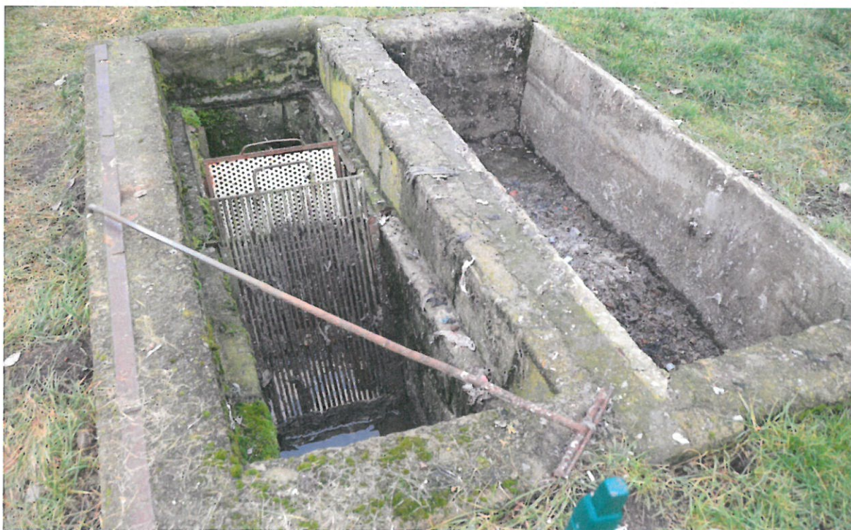
Fot. nr 6. Komora kraty ręcznej z ociekaczem skratek (kieszeń boczna)
