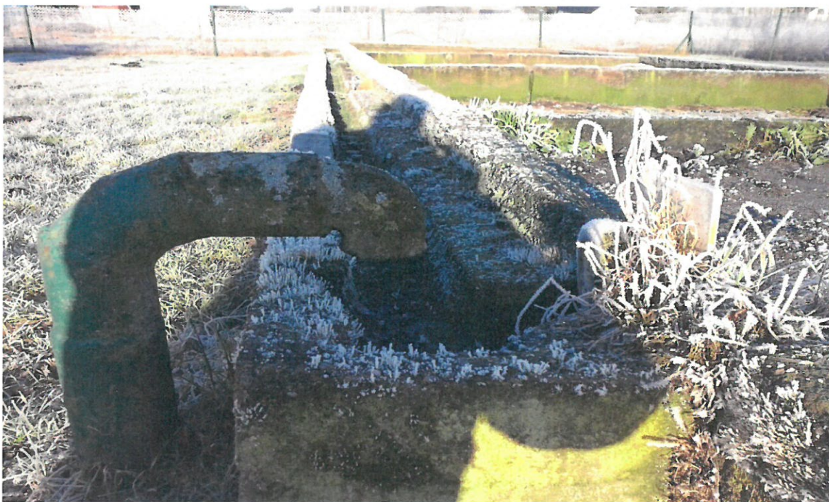
Fot. nr 8. Koryto rozdzielcze z rurą dopływu osadu
