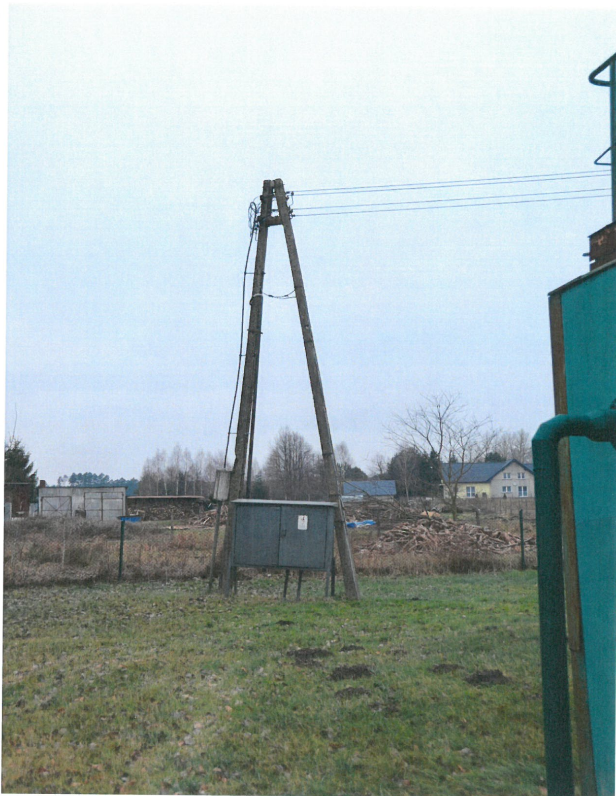
Fot. nr 9. Słup i sieć napowietrzna nn 0,4 kV na terenie działki do usunięcia
