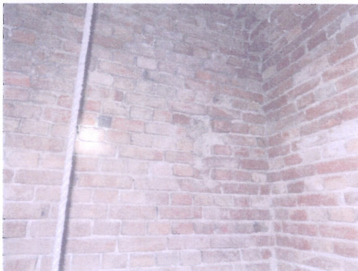
FOT.36. WIEŻA, POZIOM IV
