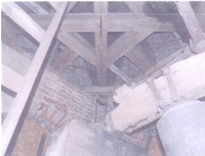
FOT.37. WIEŻA, POZIOM V
