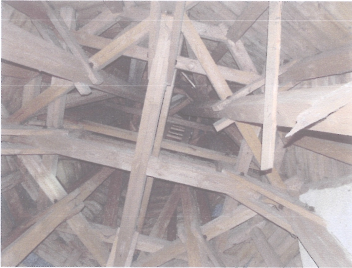
FOT.40. WIEŻA, POZIOM VIII
