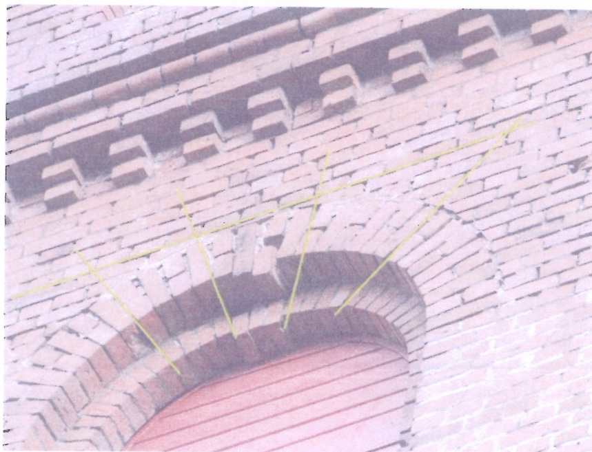
SPIĘCIE USZKODZONEGO NADPROŻA Z FOT.6.
