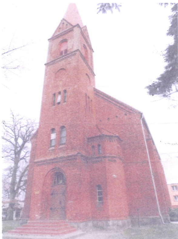
FOT. 1. ELEWACJA ZACHODNIA, WIDOK OGÓLNY
