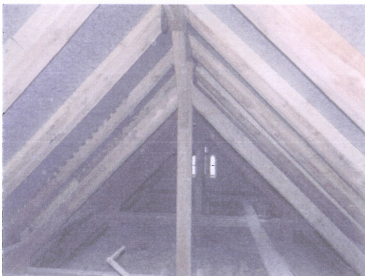
FOT.35. WNĘTRZE KOŚCIOŁA, WIDOK NA WIĘZBĘ DACHOWĄ
