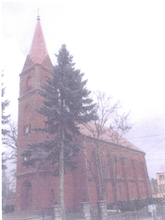
FOT.25.ELEWACJA POŁUDNIOWA, WIDOK OGÓLNY
