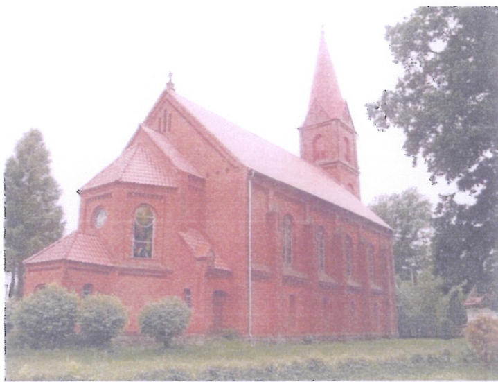
FOT.13.ELEWACJA PÓLNOCNA, WIDOK OGÓLNY
