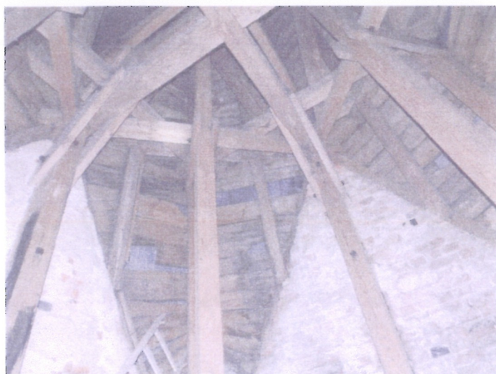
FOT.39. WIEŻA, POZIOM VII
