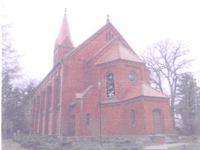
FOT.7.ELEWACJA WSCHODNIA, WIDOK OGÓLNY
