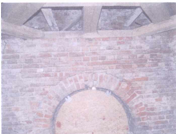
FOT.38. WIEŻA, POZIOM VI
