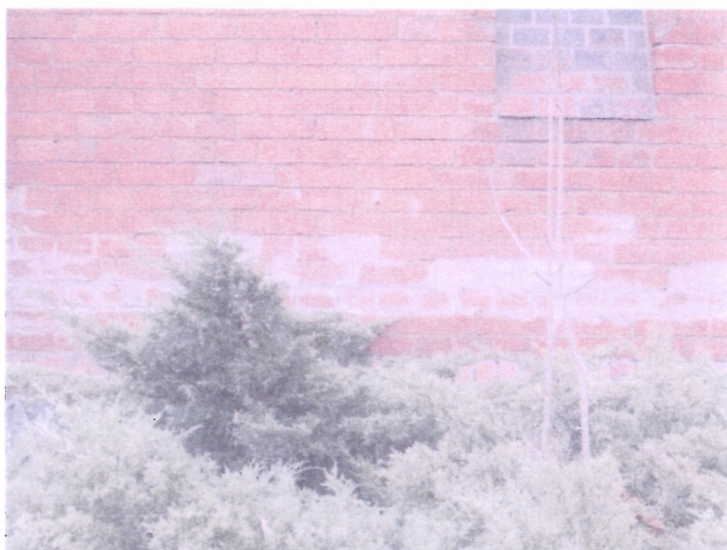
FOT.28. POŁUDNIOWA, ZACIERKI I ŁATY CEMENTOWE W MIEJSCACH UBYTKÓW
