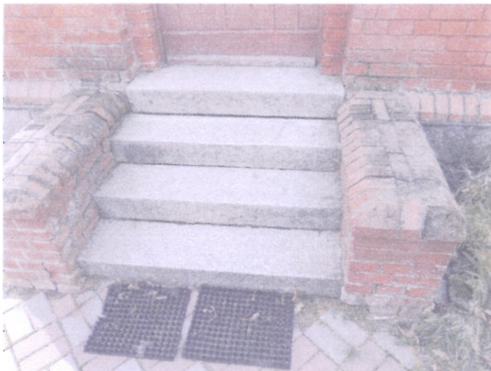
FOT.12.ELEWACJA WSCHODNIA, SCHODY GRANITOWE
