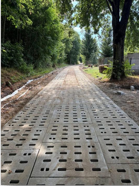
Zdjęcie 11 Budowa drogi w miejscowości Sieranie
