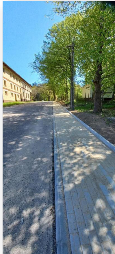
Zdjęcie 9 Budowa chodnika w Strzekęcinie
