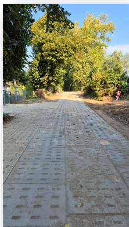
Zdjęcie 4 Budowa drogi gminnej z płyt YOMB w m. Sieranie
