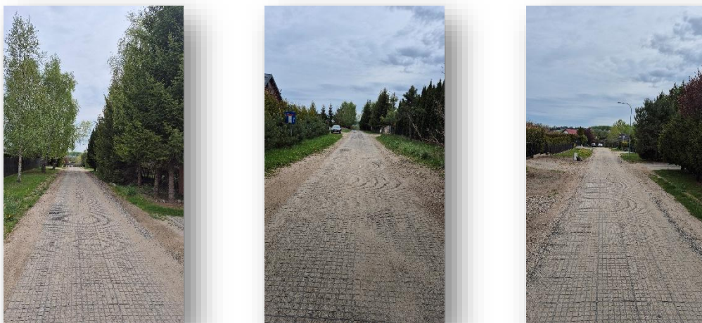
Zdjęcie 1 Remont drogi na działce 413/29 obr. Konikowo
