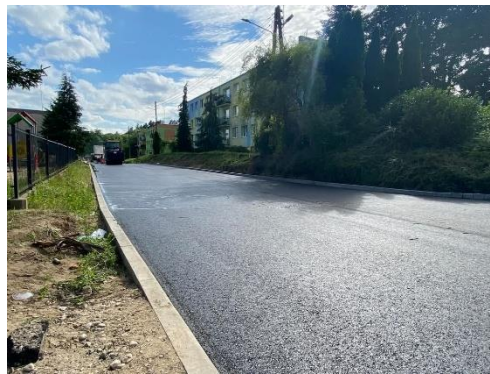
Zdjęcie 6 Przebudowy drogi gminnej w miejscowości Strzekęcino
