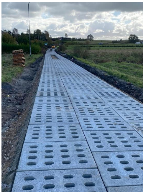
Zdjęcie 3 Przebudowy drogi gminnej na odcinku Kępa Świeszyńska – Olszak
