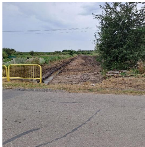
Zdjęcie 100 Rów CJ po konserwacji
