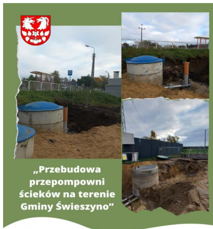
Rysunek 5 Przebudowa przepompowni ścieków na terenie Gminy Świeszyno
