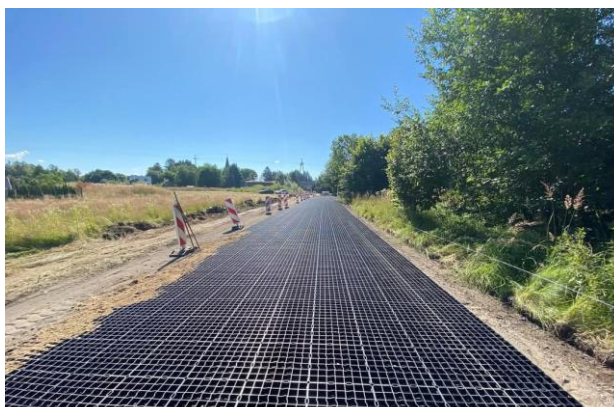
Zdjęcie 7 Remont części drogi gminnej w miejscowości Świeszyno
