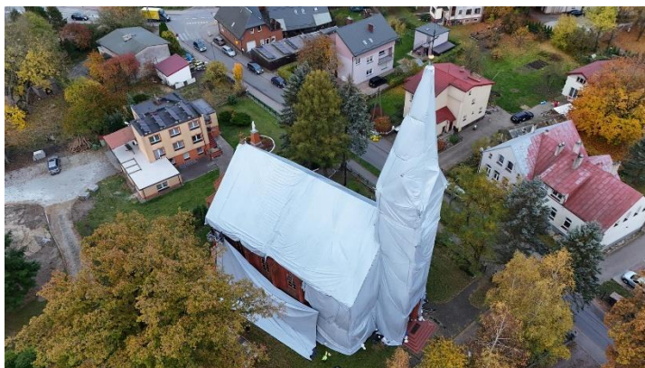
Zdjęcie 106 Przeprowadzenie prac konserwatorskich kościoła pw. Narodzenia Najświętszej Maryi Panny w Świeszynie
