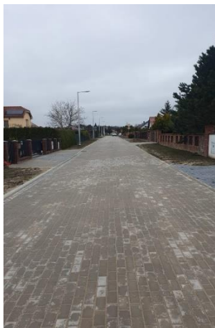
Zdjęcie 4 Przebudowy drogi gminnej w miejscowości Niekłonice
