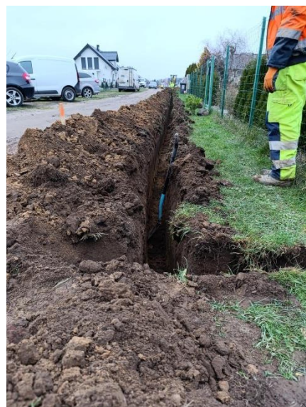
Zdjęcie 108 Prace montażowe światłowodu
