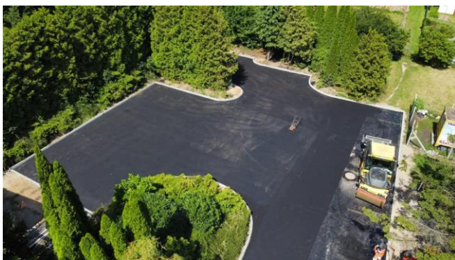
Zdjęcie 5 Przebudowy drogi gminnej w miejscowości Strzekęcino
