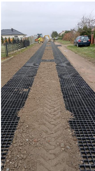
Zdjęcie 8 Remont części drogi gminnej w miejscowości Konikowo
