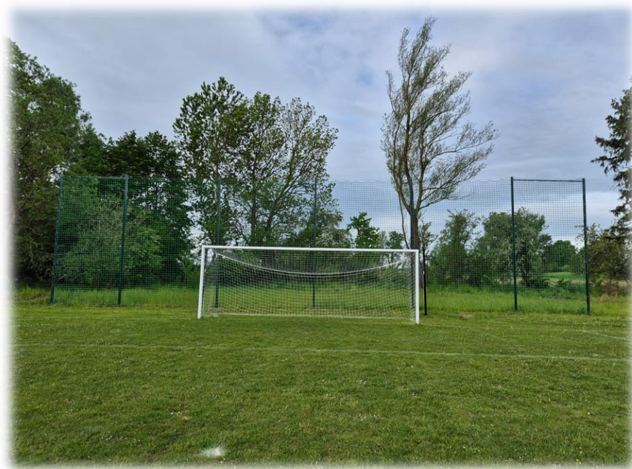
Zdjęcie 107 Budowa piłkochwyłów na boisku sportowym w m. Mierzym
