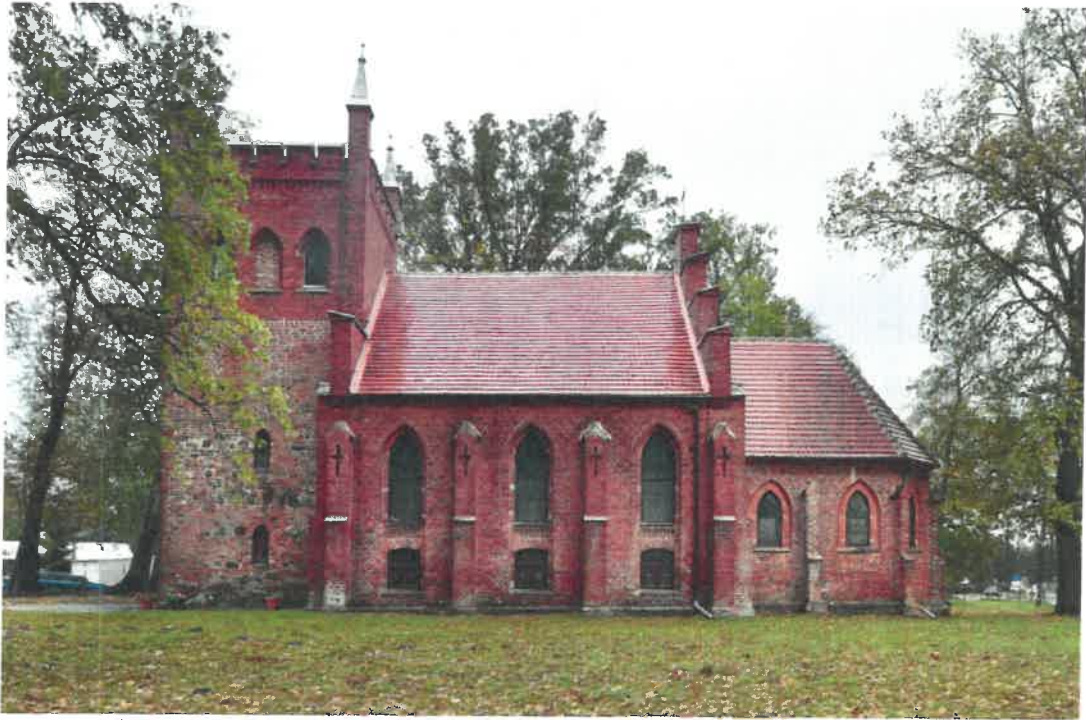
Fot.2 Widok od południa. Korpus nawowy powstał w 1852 roku. Prezbiterium w I połowie XIV w. Wieża w prawdopodobnie w XV oraz w 1852 (górną część). Okna w dolnej części elewacji korpusu wybito w 1857 r.
