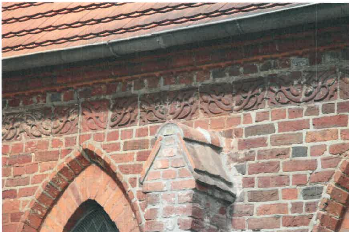
Fot.6 Prezbiterium, fryz z ornamentem roślinnym oraz ostrołuki okien z I połowy XIV w.
