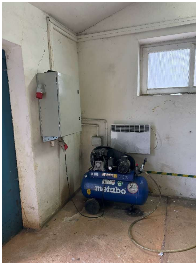
Fot. 6. Istniejący budynek SUW w Zegrzu Pomorskim – sprężarka i rozdzielnica elektryczna
