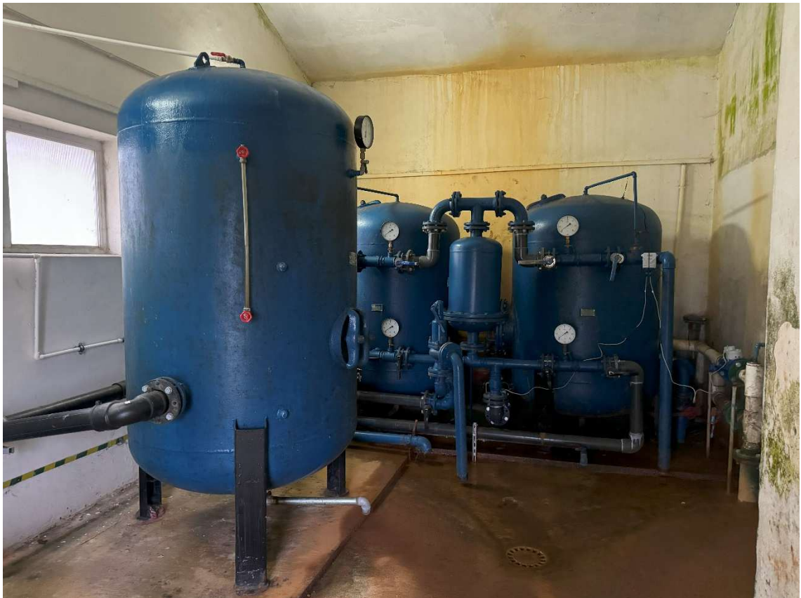
Fot. 5. Istniejący budynek SUW w Zegrzu Pomorskim – zestaw filtrów i hydrofor
