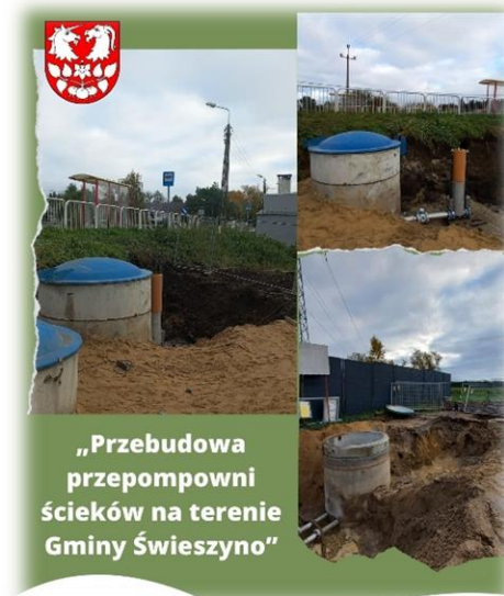
Zdjęcie 7 Przebudowy przepompowni ścieków na terenie Gminy Świeszyno
