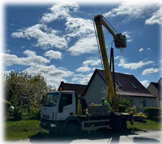
Zdjęcie 9 Wymiana niskoenergetycznych opraw oświetleniowych
