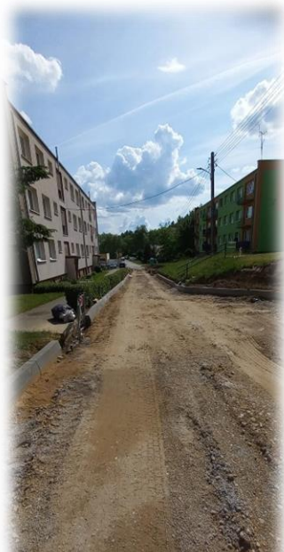
Zdjęcie 8 Realizacja zadania pn.: „Poprawa bezpieczeństwa ruchu pieszych poprzez przebudowę pasa drogowego drogi wewnętrznej w miejscowości Strzekęcino”
