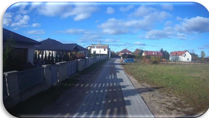
Zdjęcie 3 Przebudowa drogi w m. Niekłonice
