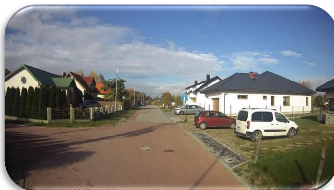
Zdjęcie 1 Przebudowa drogi w m. Konikowo
