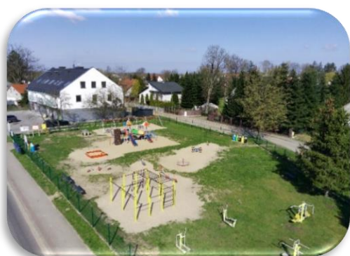
Zdjęcie 71 Budowa centrum turystyczno-rekreacyjnego w Świeszynie
