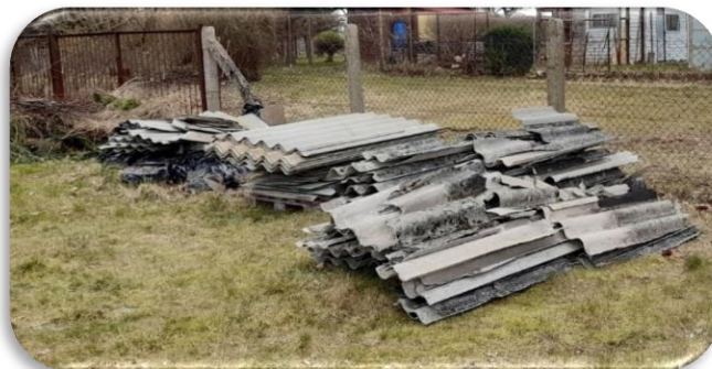
Zdjęcie 4 Usuwanie wyrobów azbestowych
