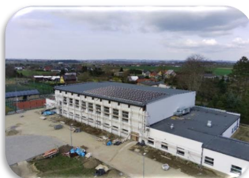
Zdjęcie 70 Budowa hali sportowej przy SP w Świeszynie
