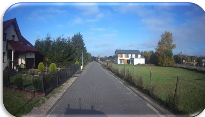
Zdjęcie 2 Przebudowa drogi w m. Chałupy
