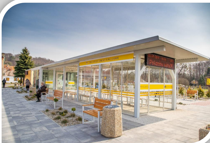
Fotografia 9. Centrum przesiadkowe w Polanowie
