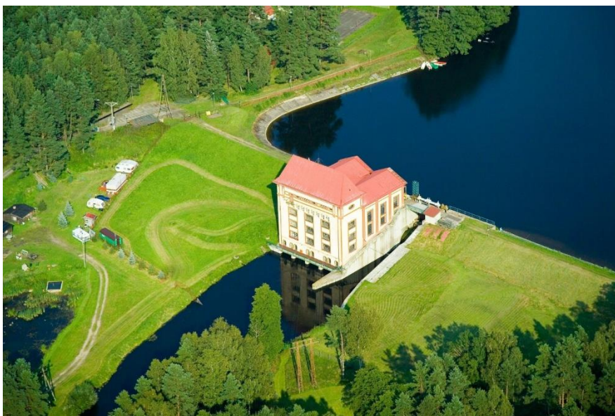
Zdjęcie 18 Elektrownia Wodna Hajka
