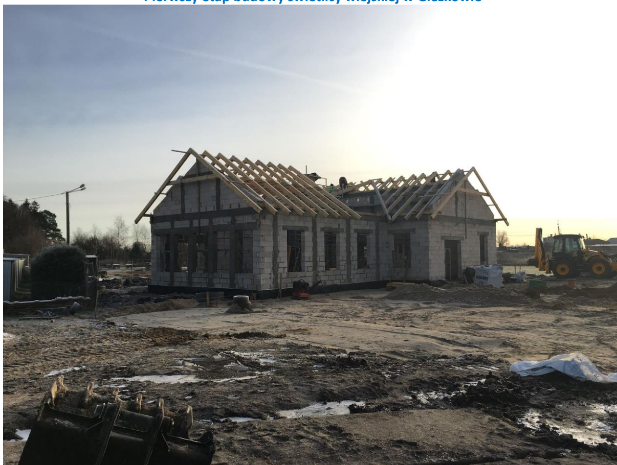
Pierwszy etap budowy świetlicy wiejskiej w Giezkowie
