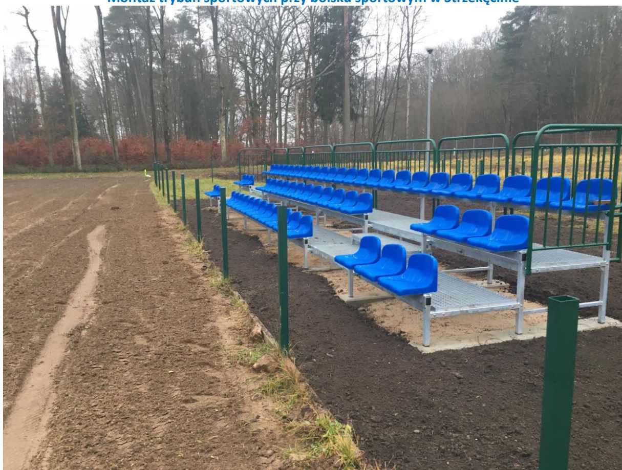
Montaż trybun sportowych przy boisku sportowym w Strzekącinie
