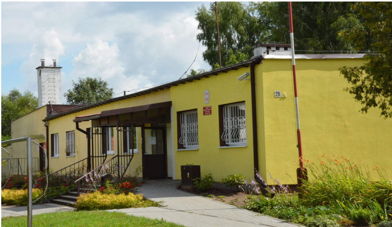
Ilustracja 6. Budynek Miejskiego Ośrodka Pomocy Społecznej, biblioteki i świetlicy w Niedalinie
